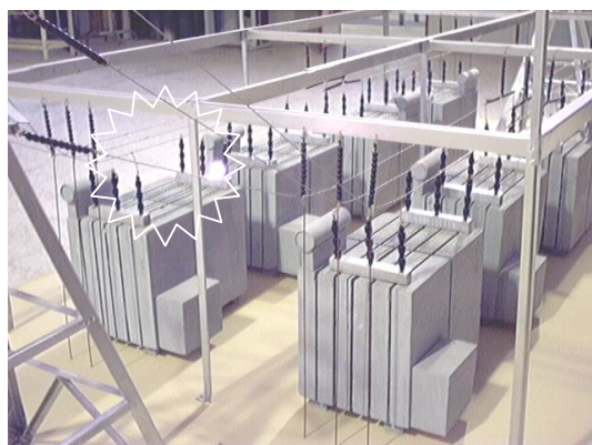
شکل ۷- قوس الکتریکی ناشی از اتصال کوتاه در خطوط برق ولتاژ بالا بعث تماس الیاف گرافیت.
